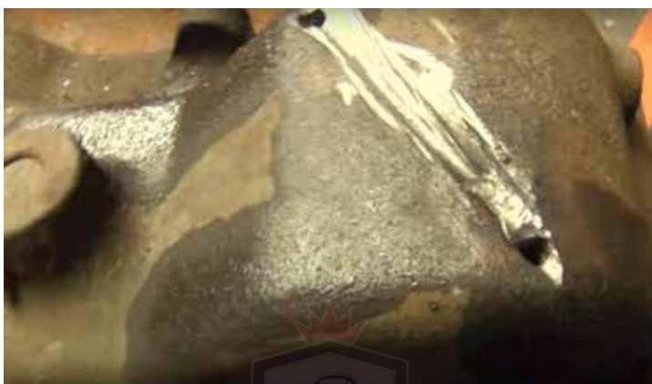
سنگ زنی و آماده سازی محل ترک
