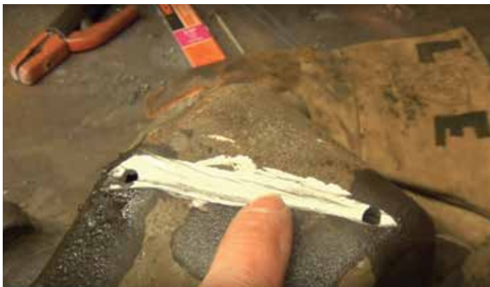
سنگ زنی و آماده سازی محل ترک
