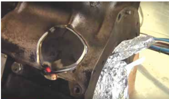
جوشکاری نقطه ای ایجاد شده جهت فیکس کردن قطعه فولادی در محل کندی
